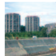
Überbauung Hohenacker: EMCH lieferte 11 Personellifte. Darunter jener für das grösste Wohnhochhaus im Kanton Bern mit 27 Haltestellen und 75 Meter Förderhöhe.
