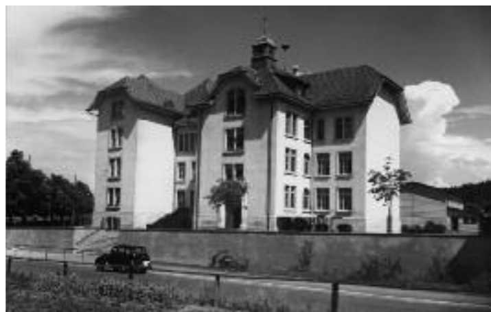
Schulhaus Höhe von der Morgenstrasse her, Aufnahme um 1940.
